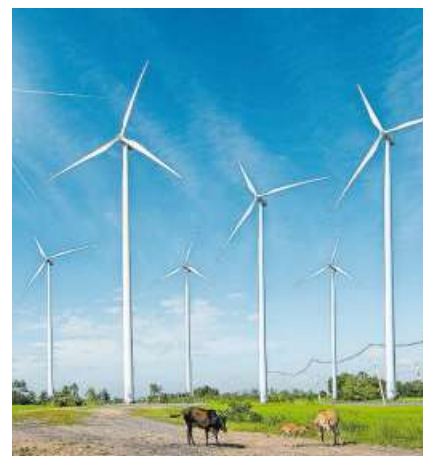
Gutes tun und daran verdienen: Windfarm in Thailand.
