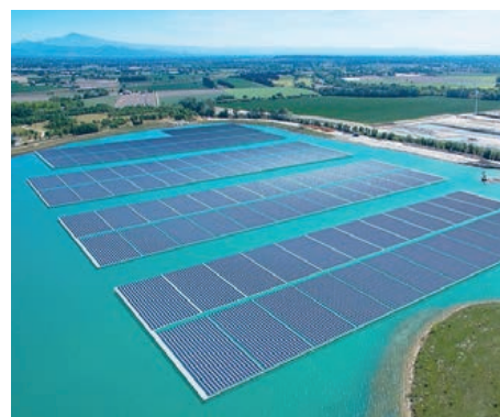
Die grösste europäische PV-Anlage in Europa schwimmt auf einem See in Frankreich. Über 46'000 Module versorgen etwa 4'700 Haushalte. Bild: ©Akuoenergy
